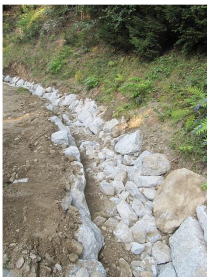
Enrochement et place de dépôt
