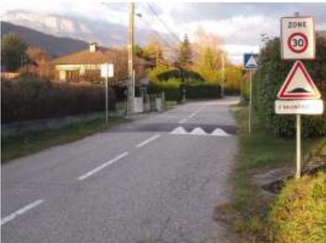
**Sécurisation des Curtets avec la réalisation de 3 dos d'âne** en remplacement des coussins berlinois souvent dégradés par les engins de déneigement
