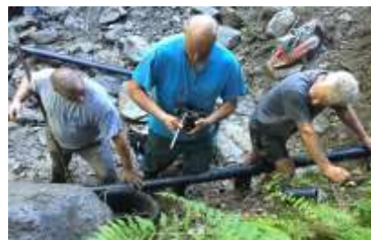
Alain lors d'une intervention sur le réseau d'eau en 2017, conduite « chez Legrand » traversant le Nant des Fruitières
